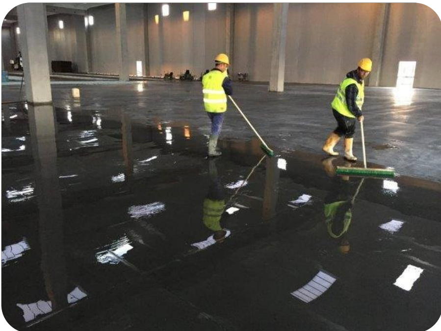
Posa della finitura superficiale antipolvere ai Silicati
