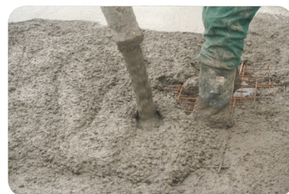
Pompaggio del calcestruzzo fibrorinforzato
