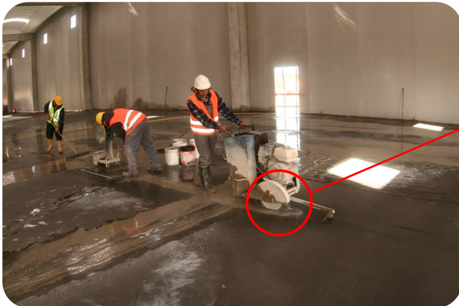
Realizzazione dei tagli per la formazione dei giunti di controllo
