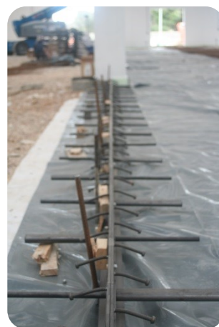
Particolare giunto di costruzione
