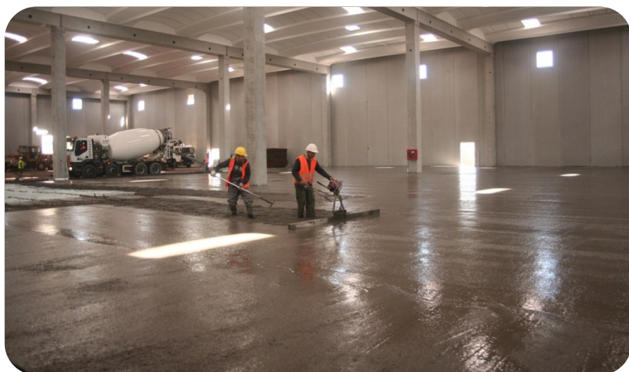
Getto e stesa del calcestruzzo
