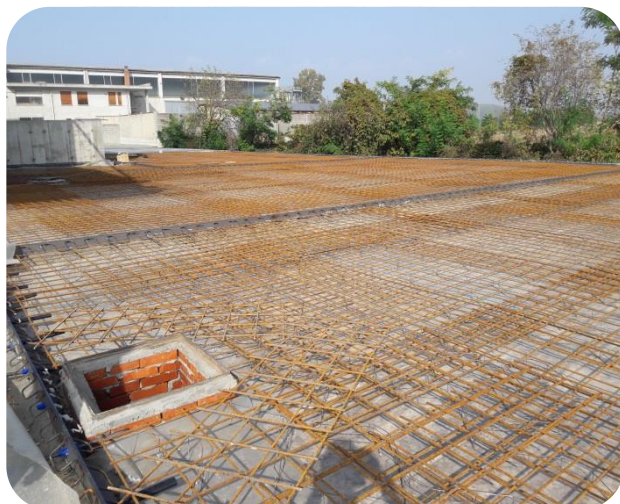
Armatura della pavimentazione esterna Joint-Less
