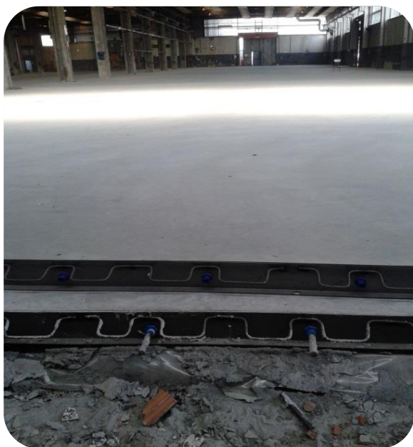
Pavimentazione interna pre trattamento superficiale
