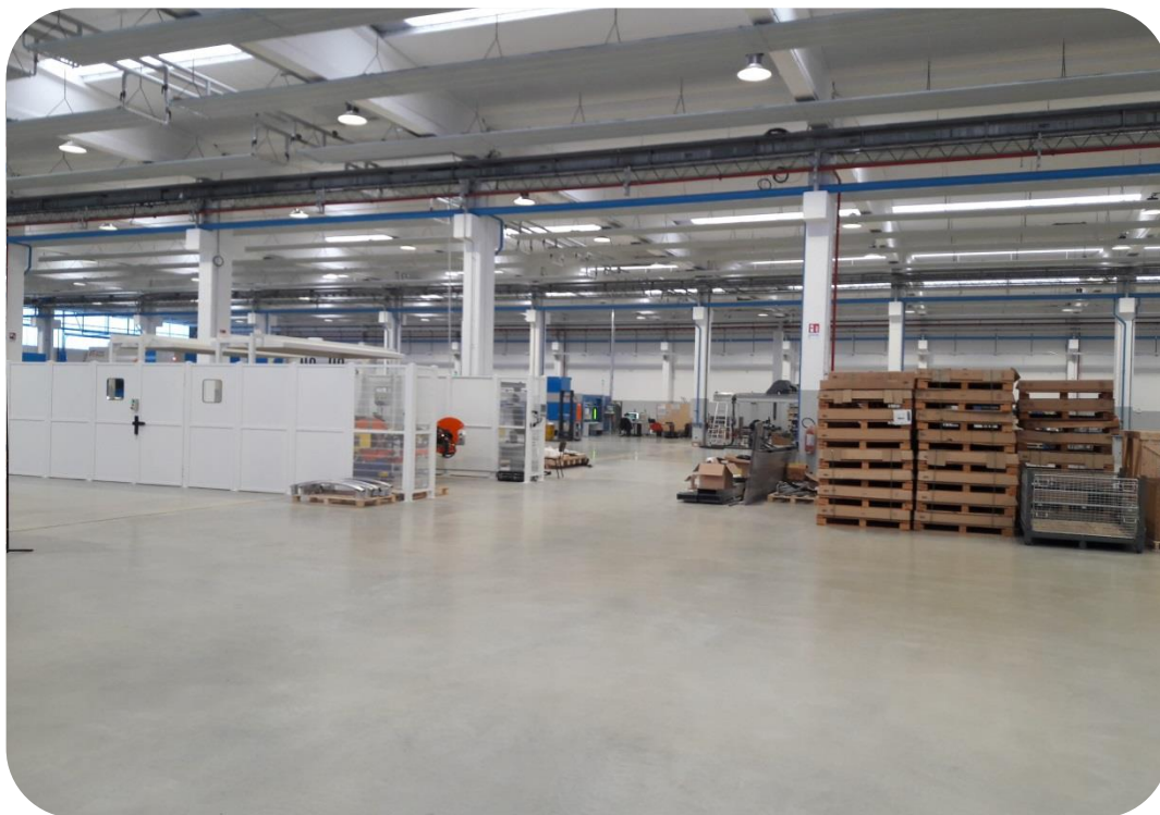
La pavimetnaizione interna in esercizio
