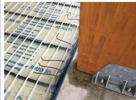
Figura 1. Particolare ferri di collegamento Cordolo-Pavimentazione
