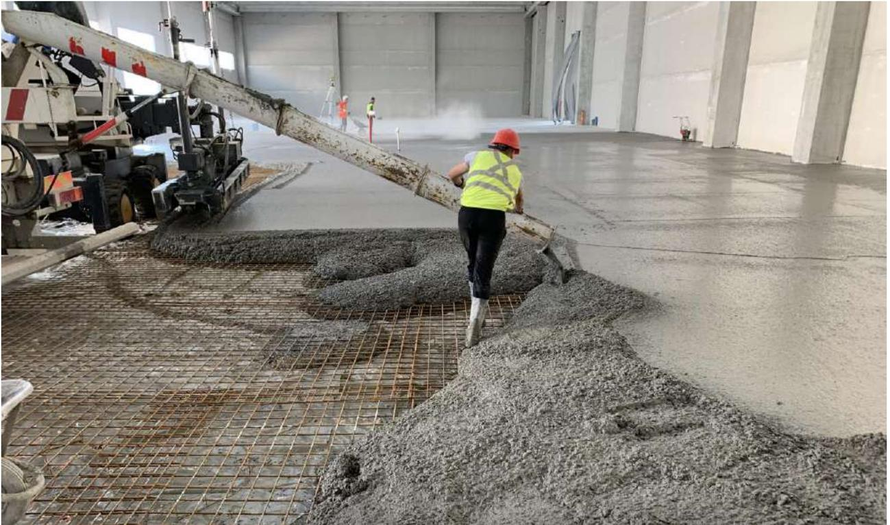
**Figura 2.** Fasi di getto della pavimentazione industriale con fibre polimeriche FIBRAG® POLY: PSF 55-TP
