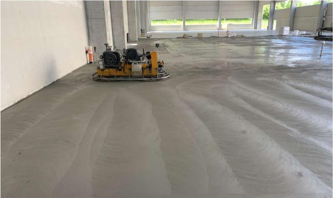
**Figura 6.** Fase di lisciatura della pavimentazione industriale
