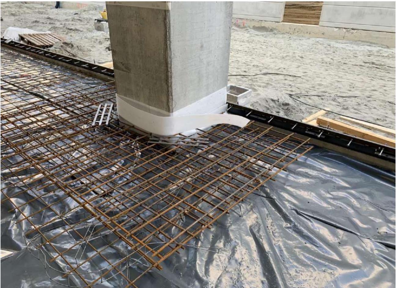
**Figura 3.** Particolare del rinforzo aggiuntivo di armatura superiore in corrispondenza di pilastri (angoli liberi) e predisposizione delle armature suppletive FIBRAG® STEEL: RUNG WLF 001
