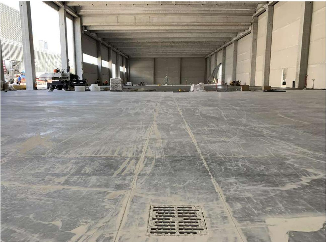
**Figura 7.** Particolare della cura adottata in fase di realizzazione di giunti di controllo paralleli ad elementi di discontinuità
