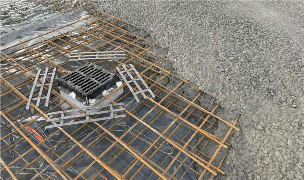
**Figura 4.** Particolare del rinforzo aggiuntivo di armatura superiore in corrispondenza di pozzetti interni (angoli liberi) e predisposizione delle armature suppletive FIBRAG® STEEL: RUNG WLF 001
