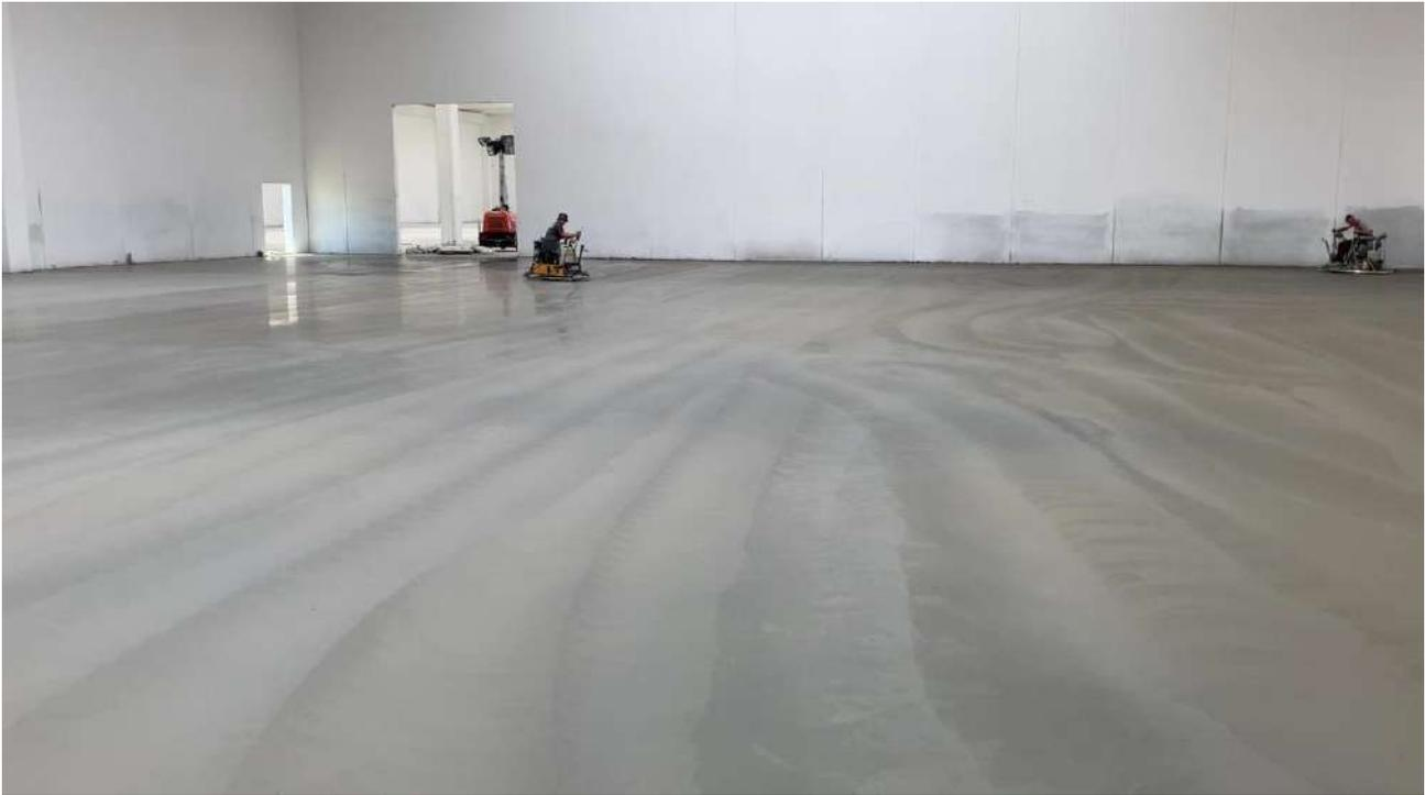
**Figura 3.** Fasi di realizzazione della pavimentazione fibrorinforzata con FIBRAG® STEEL: F-W 50/50 MT
