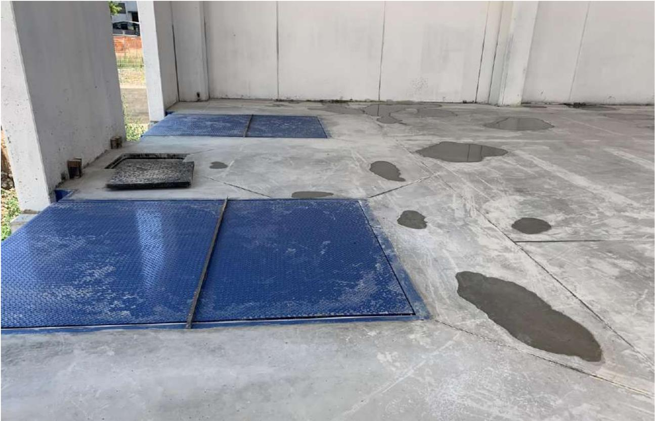
**Figura 5.** Particolare della cura adottata in fase di realizzazione di giunti di controllo in prossimità delle baie di carico
