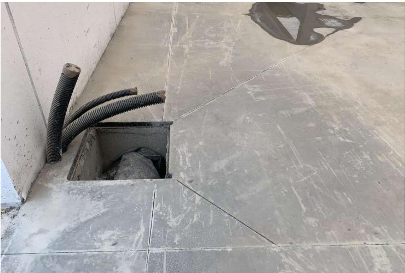
**Figura 6.** Particolare della cura adottata in fase di realizzazione di giunti di controllo in prossimità di elementi di discontinuità
