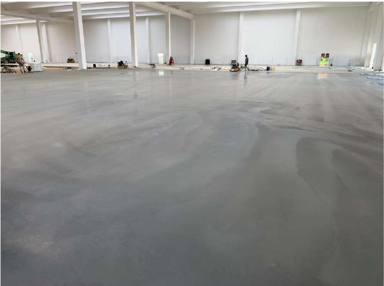
**Figura 4.** Fasi di realizzazione della pavimentazione fibrorinforzata con FIBRAG® STEEL: F-W 50/50 MT
