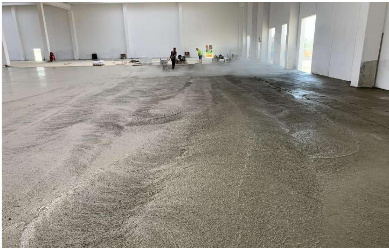
Figura 2. Fasi di realizzazione della pavimentazione fibrorinforzata con FIBRAG® STEEL: F-W 50/50 MT
