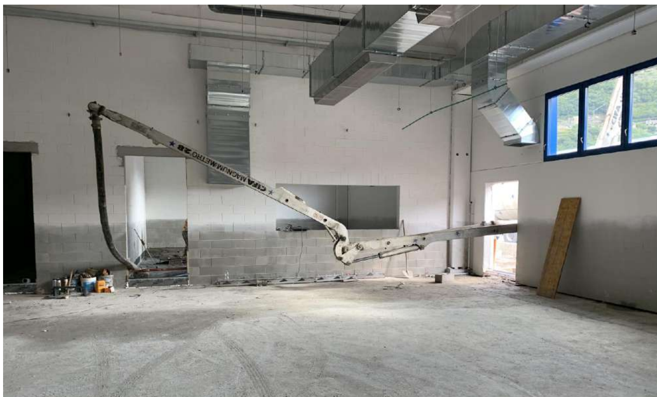
Figura 3. Getto del calcestruzzo con ausilio di autopompa
