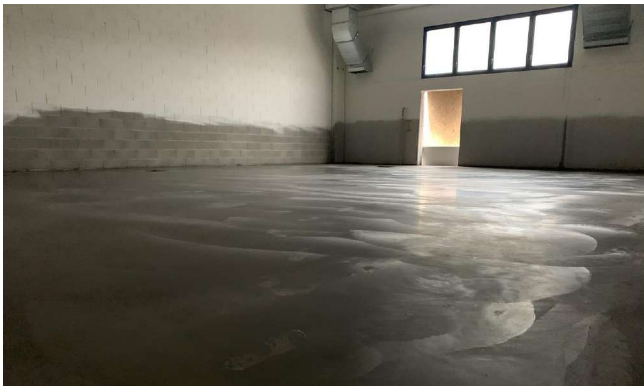
Figura 6. Vista della pavimentazione ultimata
