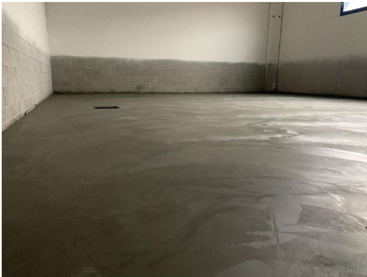
Figura 7. Vista della pavimentazione ultimata
