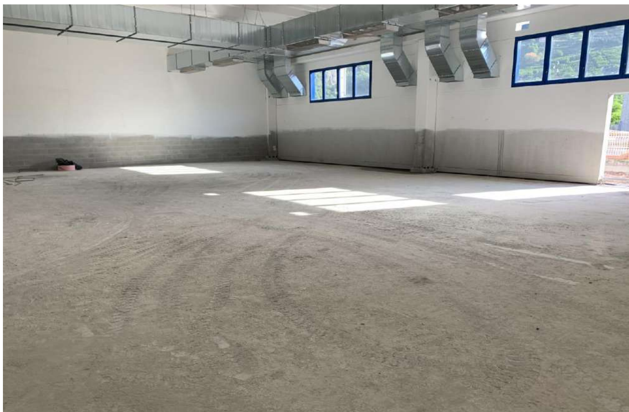
Figura 2. Preparazione del sottofondo della pavimentazione
