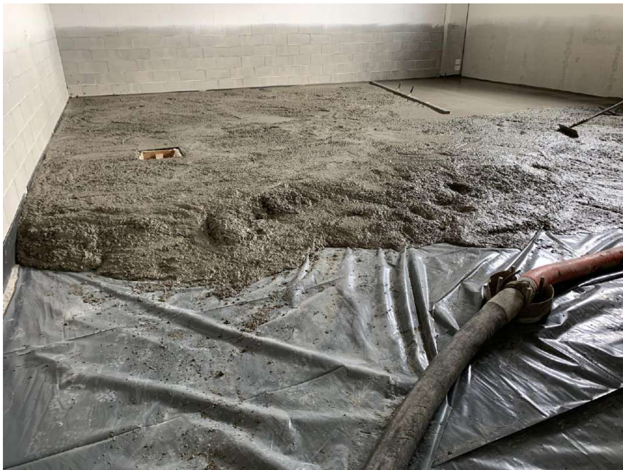
Figura 5. Fasi di getto della pavimentazione interamente fibrorinforzata con FIBRAG® POLY: PSF 55-TP
