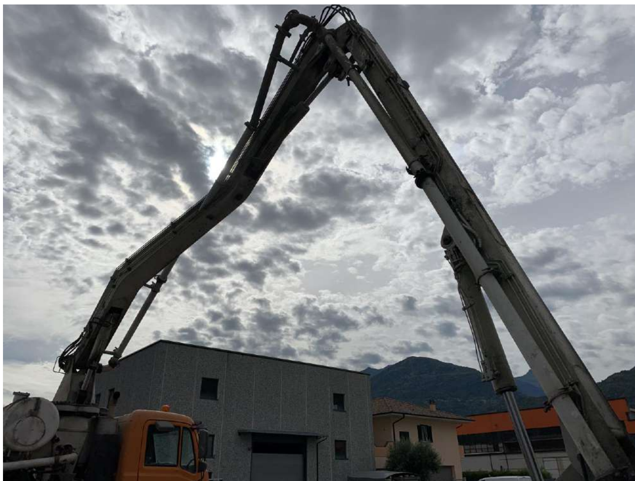
Figura 4. Getto del calcestruzzo con ausilio di autopompa
