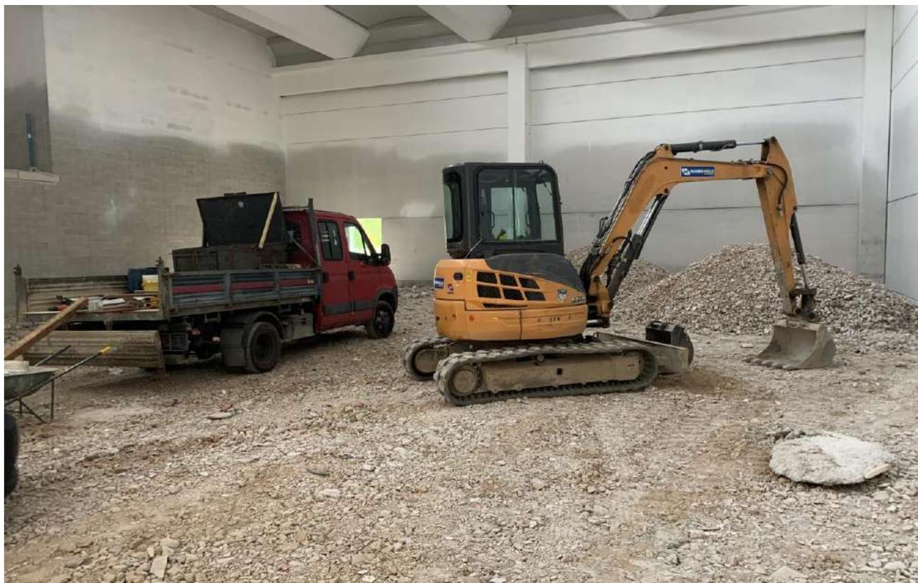
Figura 2. Preparazione del sottofondo della pavimentazione
