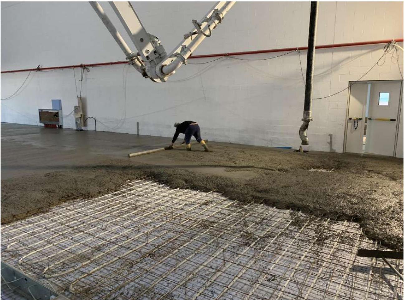
**Figura 8.** Fasi di stesura della pavimentazione fibrorinforzata con FIBRAG® POLY: PSF 55-TP – AREA 2-PACK LINE
