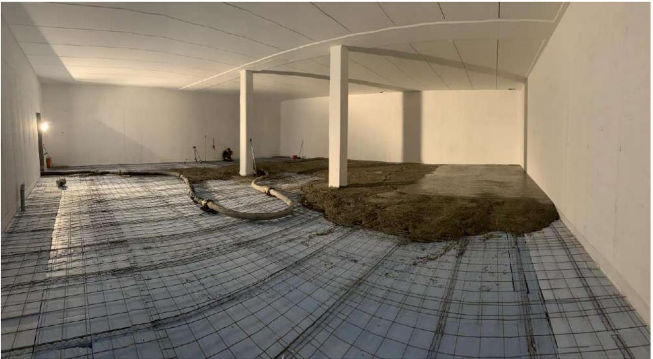
**Figura 5.** Fasi di getto della pavimentazione fibrorinforzata con FIBRAG® POLY: PSF 55-TP – AREA 3-CAVEAU
