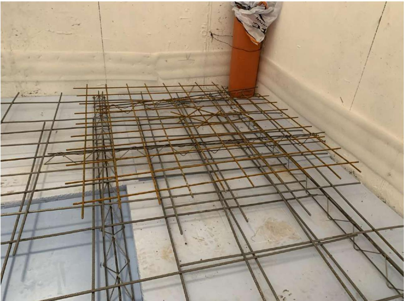
**Figura 4.** Particolare del rinforzo aggiuntivo di armatura superiore in corrispondenza degli angoli liberi come da disposizioni progettuali – AREA 3-CAVEAU
