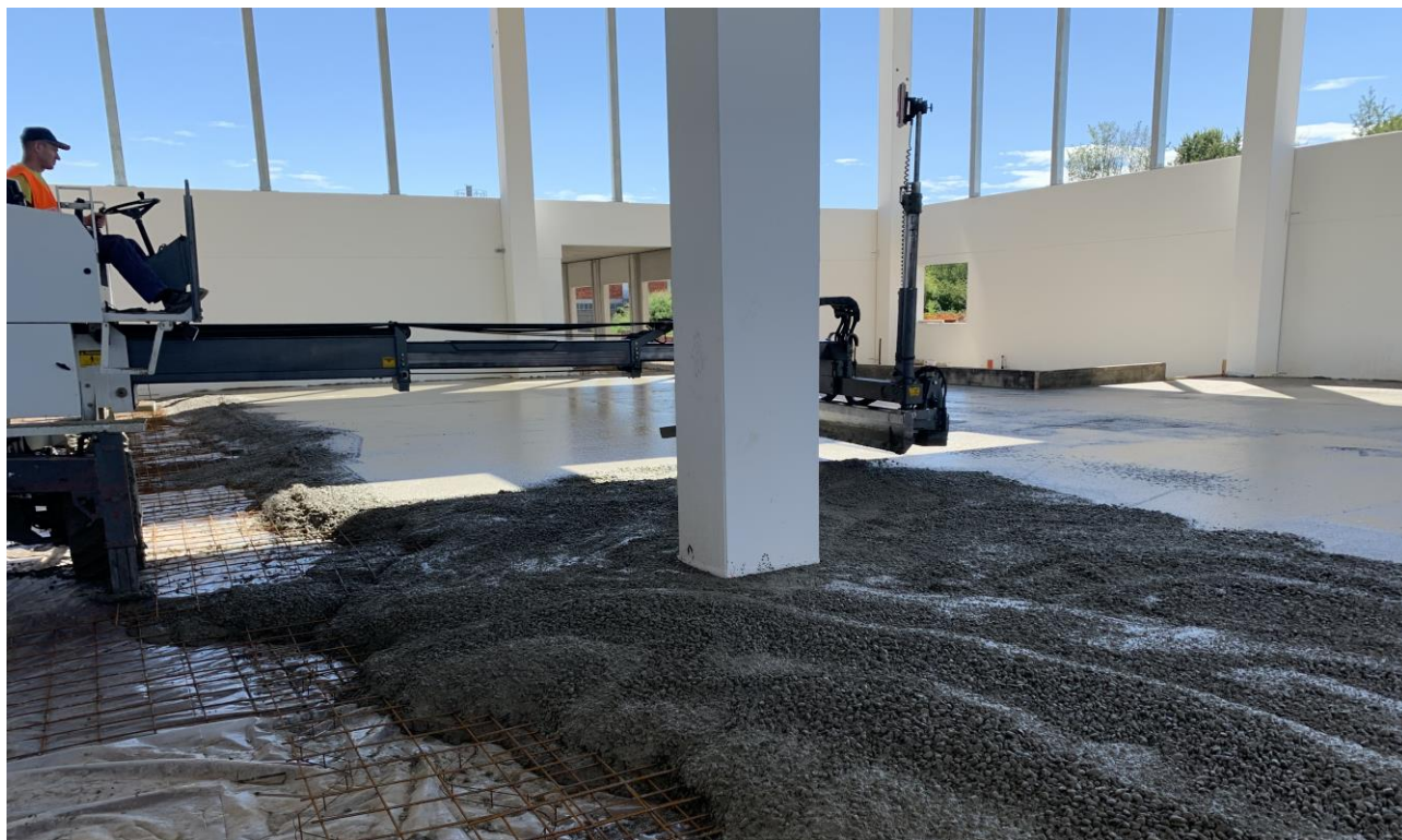
Figura 5. Fasi di getto della pavimentazione con stesa meccanizzata Laser Screed
