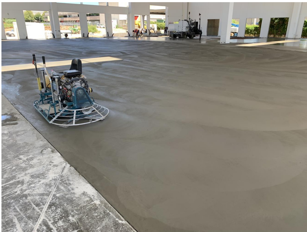
Figura 6. Particolare di ripresa di getto
