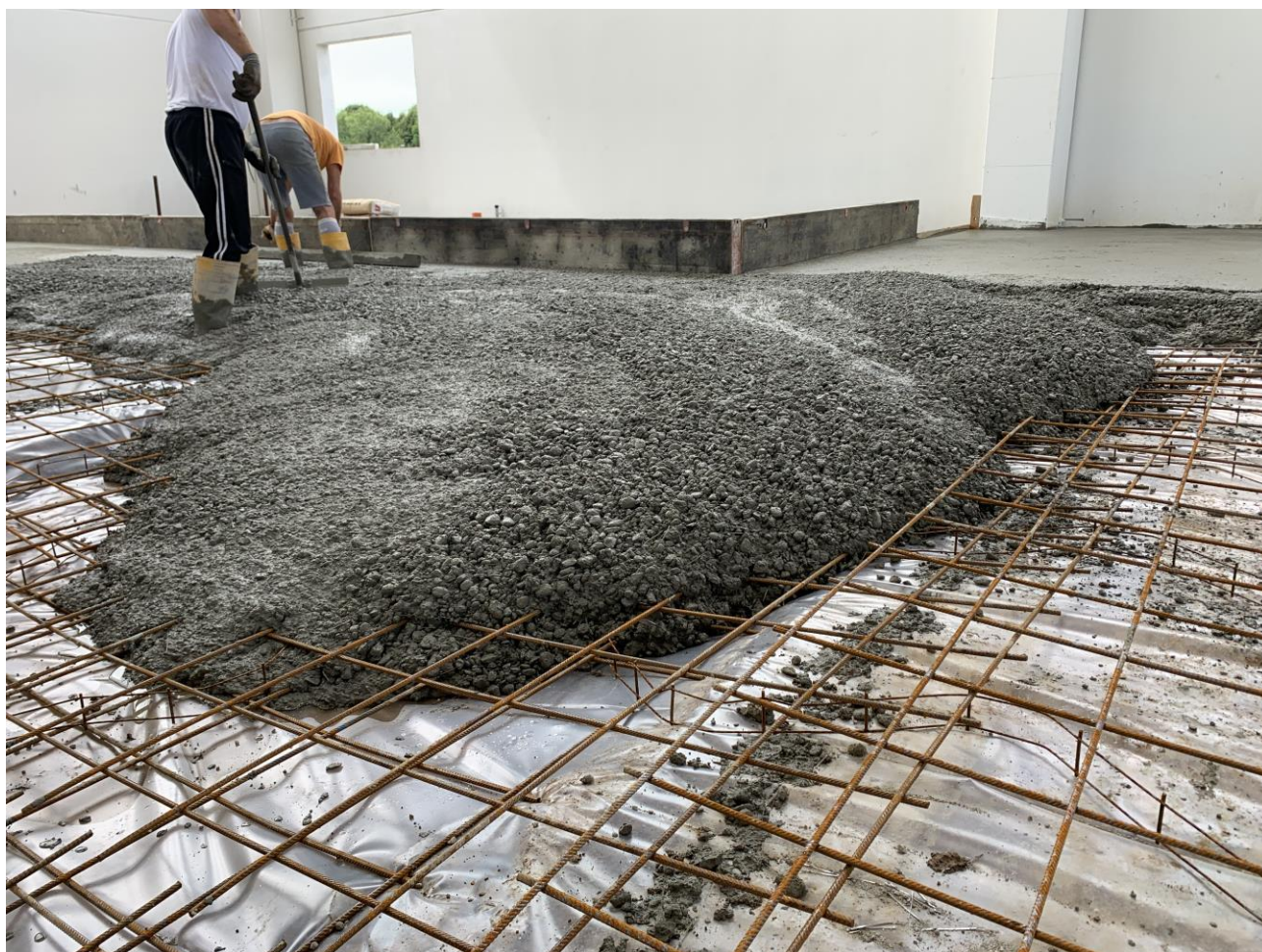
Figura 4. Fasi di getto della pavimentazione
