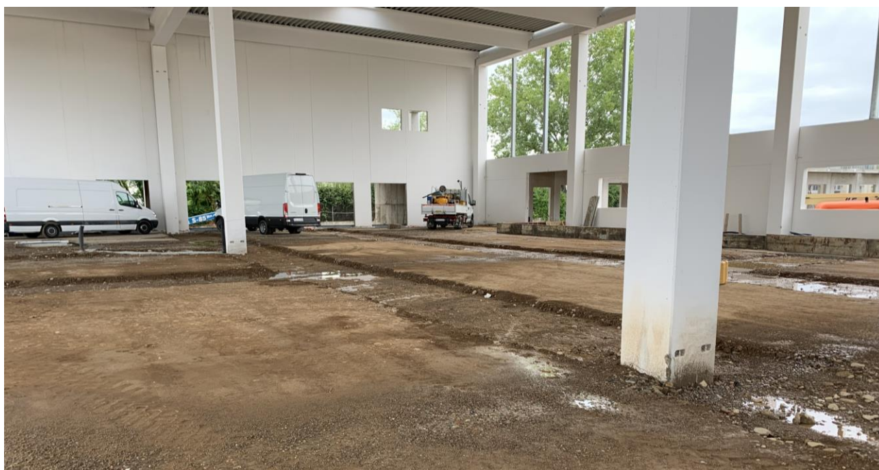
Figura 2. Preparazione del sottofondo a quote differenti
