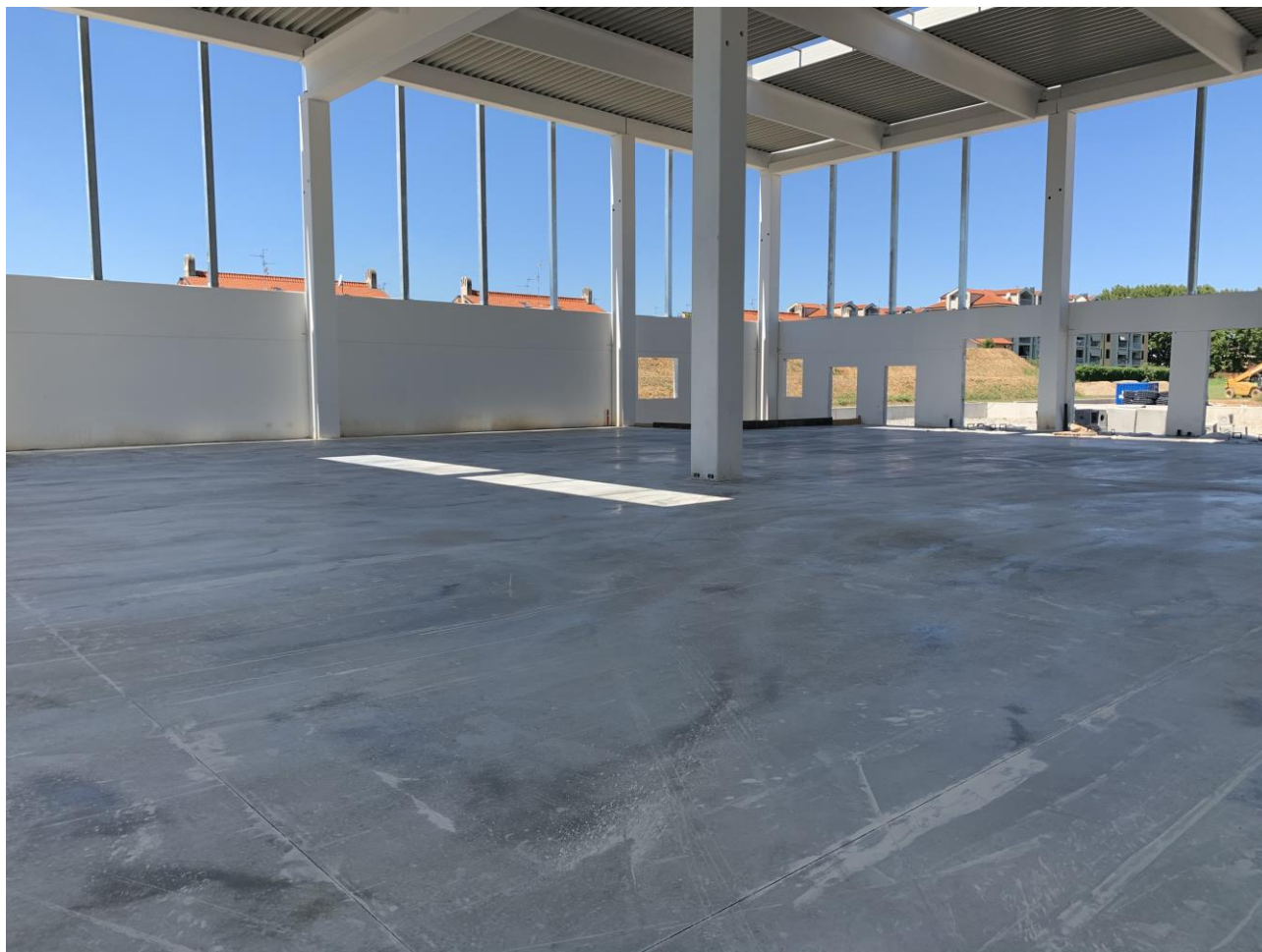
Figura 7. Vista della pavimentazione ultimata
