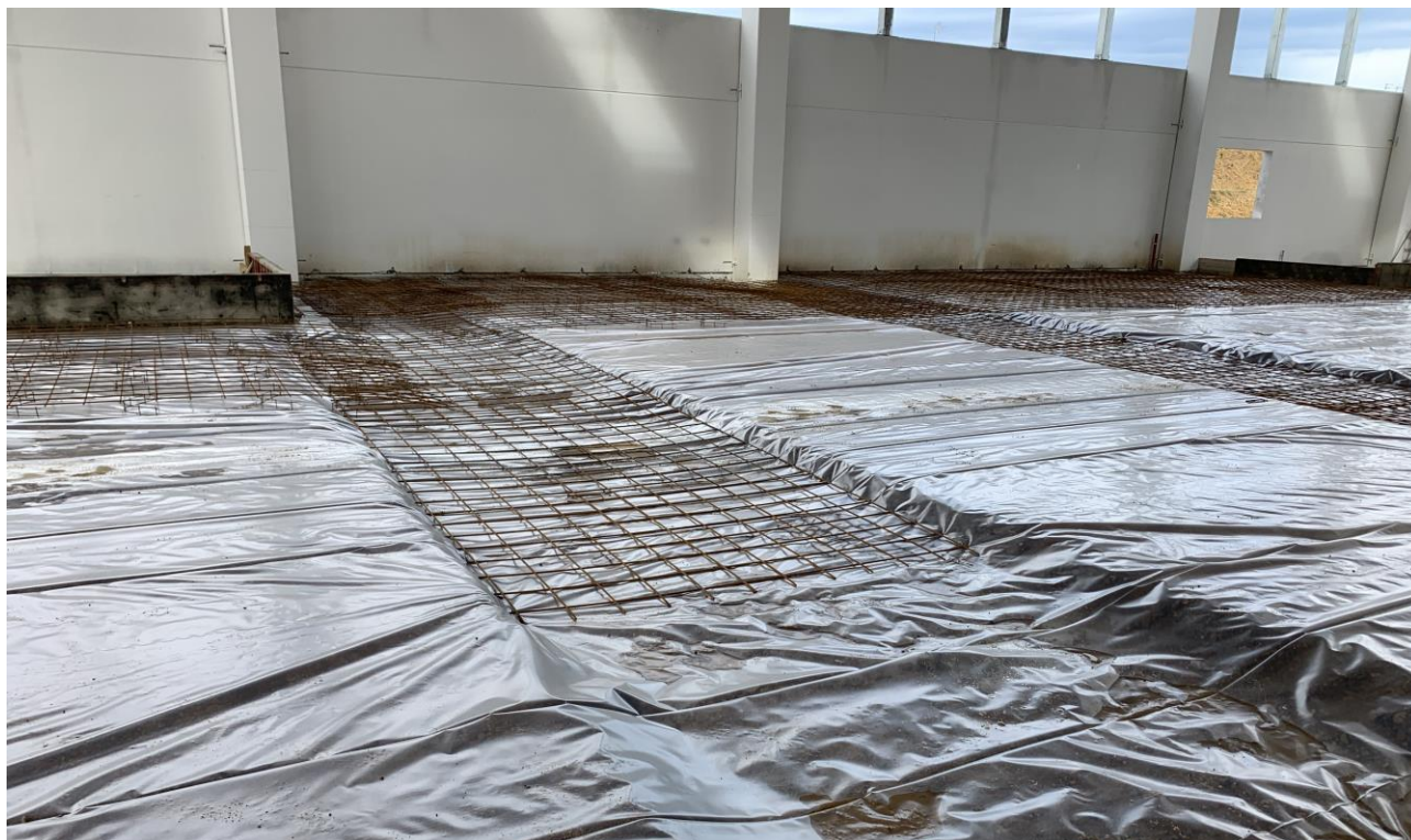
Figura 3. Posizionamento della rete elettrosaldata nella pavimentazione a differente spessore
