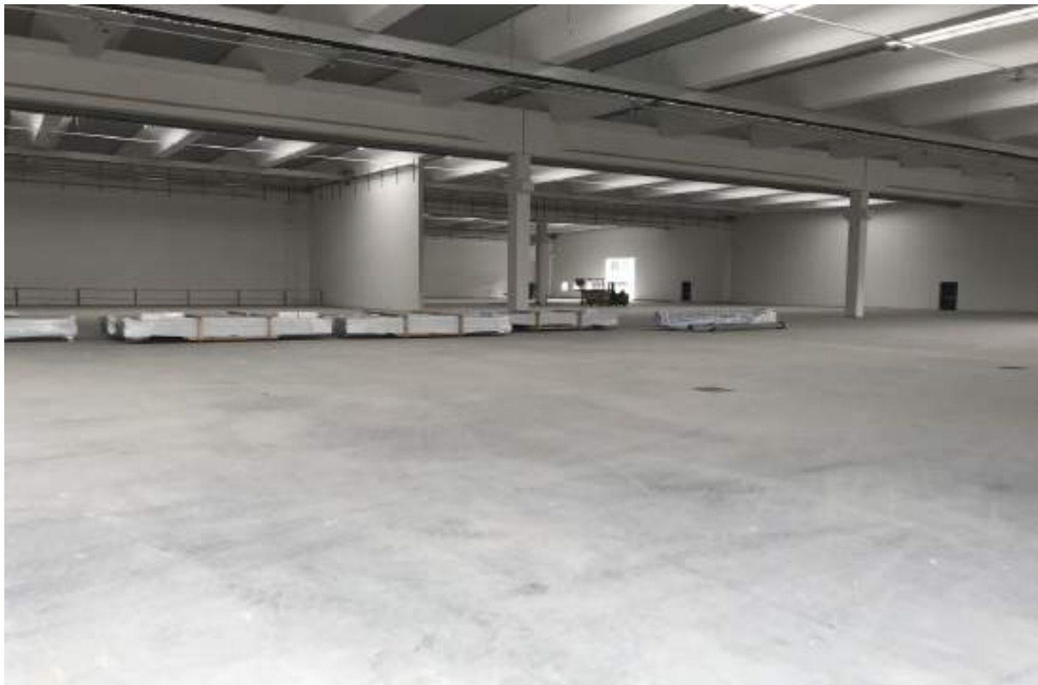
Figura 12. Vista della pavimentazione ultimata
