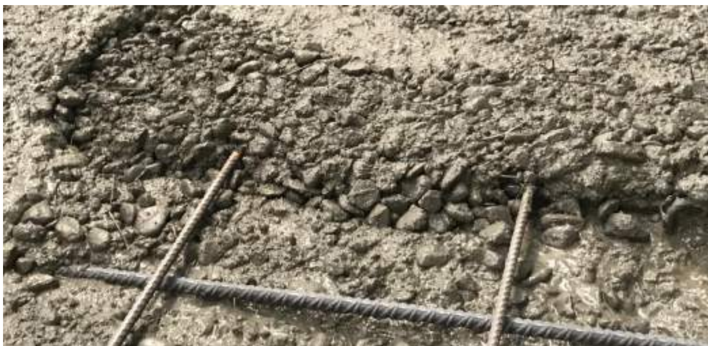
Figura 5. Particolare getti calcestruzzo fibrorinforzato con fibre FIBRAG® STEEL F-DUE 60/65 MT
