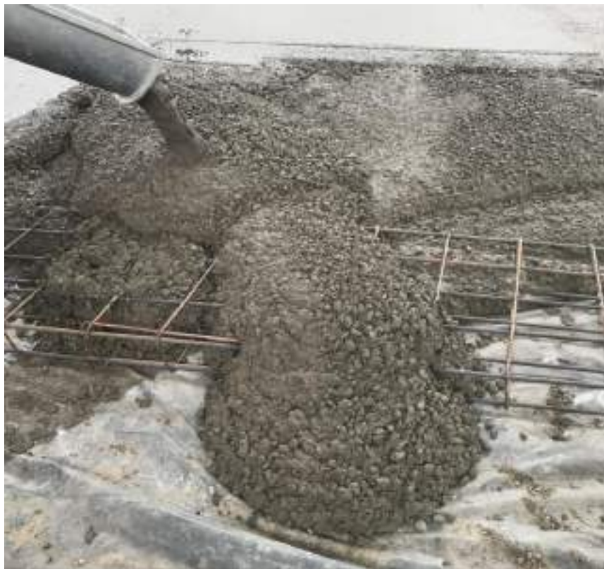
Figura 6. Fase di getto di calcestruzzo fibrorinforzato con fibre FIBRAG® STEEL F-DUE 60/65 MT
