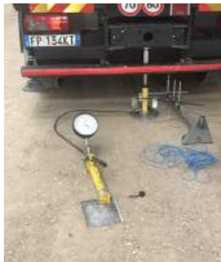
Figura 2. Prove di piastra sul sottofondo
