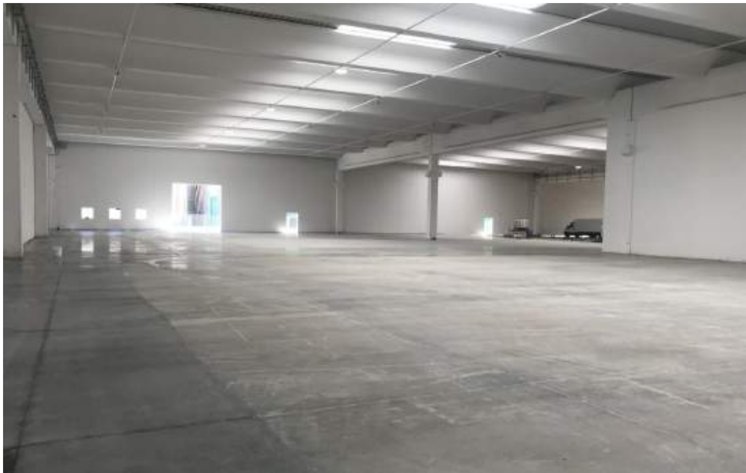
Figura 11. Vista della pavimentazione ultimata
