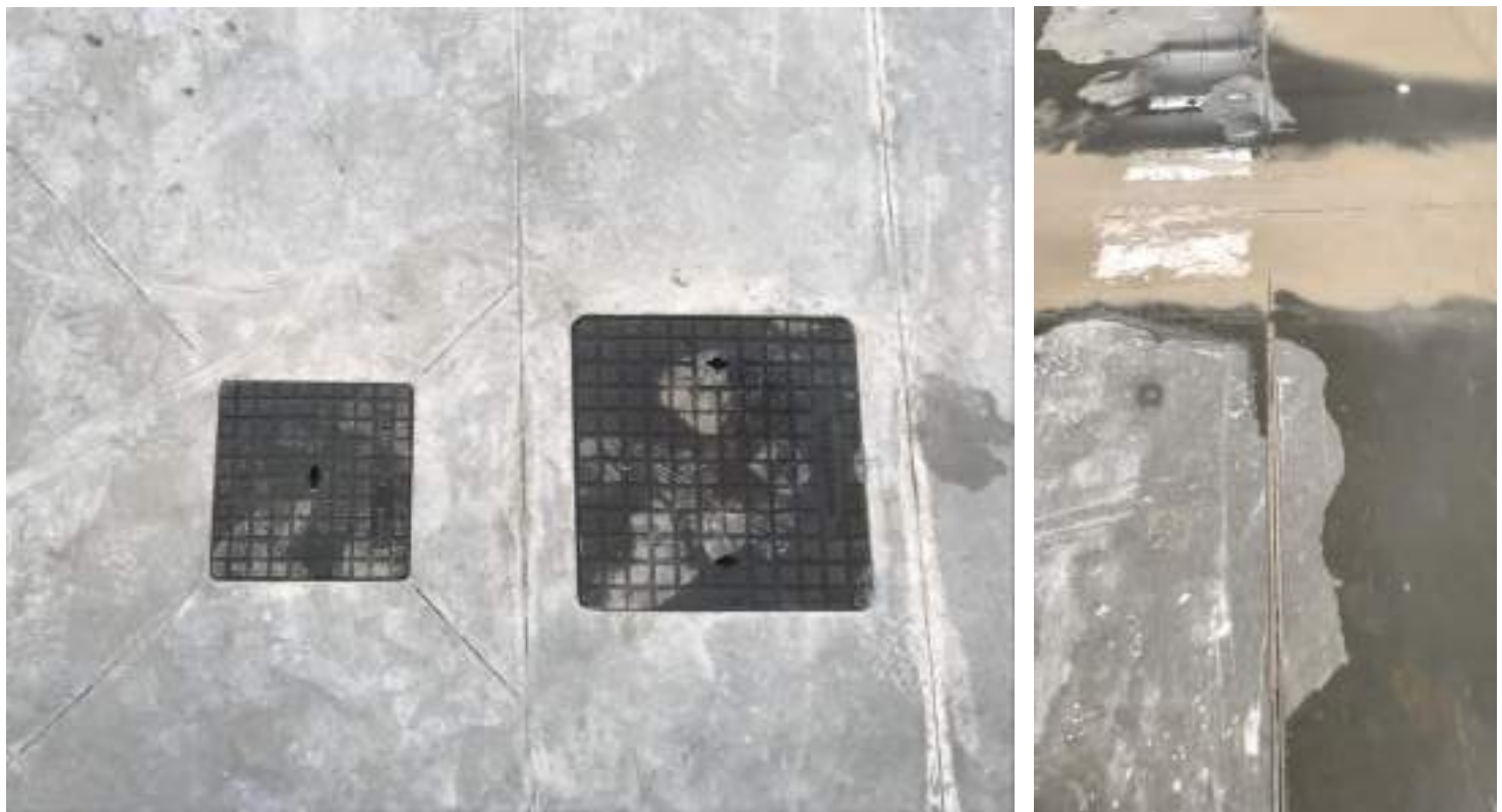
Figura 10. Particolare della cura adottata in fase di realizzazione dei giunti di controllo in prossimità di elementi di discontinuità
