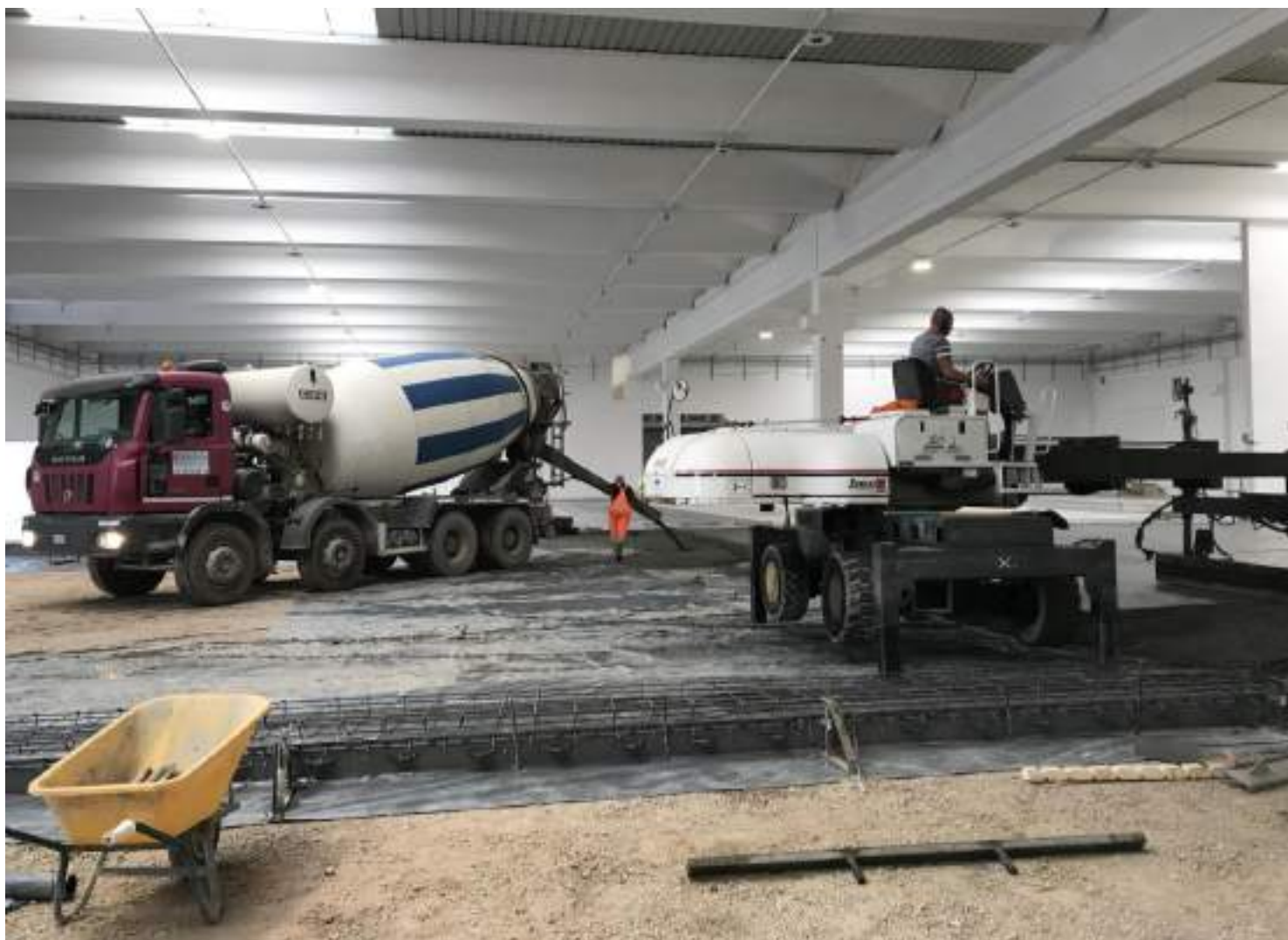
Figura 8. Fase di getto e stesura meccanizzata con vibrostenditrice Laser Screed (1)
