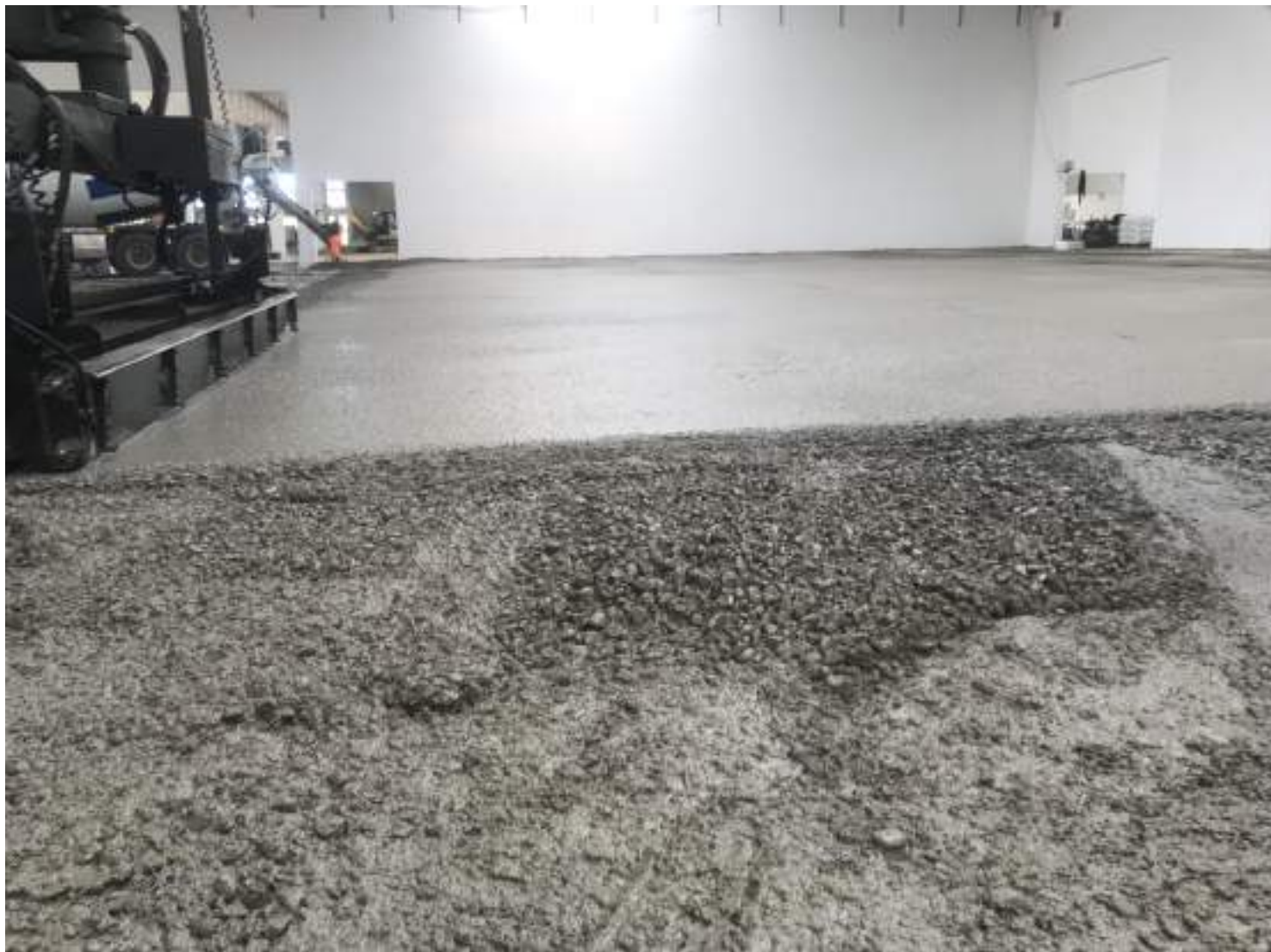
Figura 9. Fase di getto e successiva stesura meccanizzata con vibrostenditrice Laser Screed (2)
