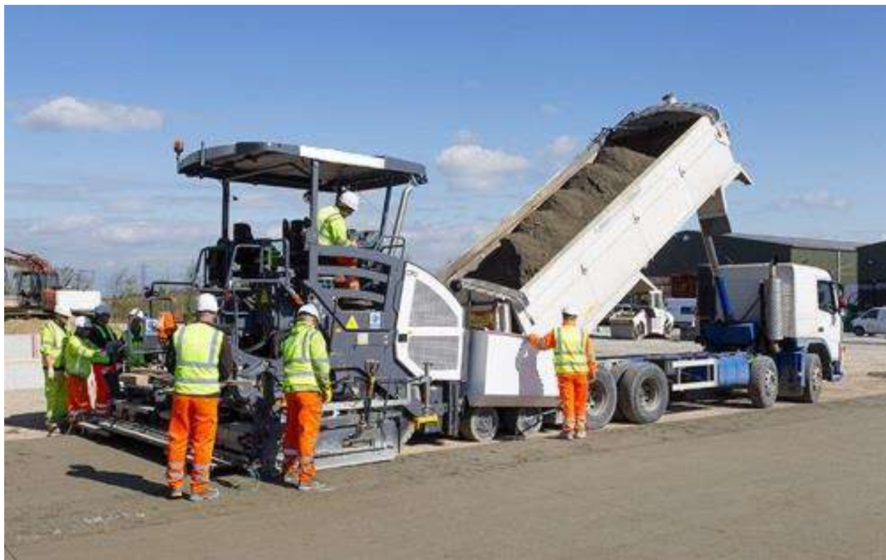
Figura 3. Realizzazione di una pavimentazione stradale
