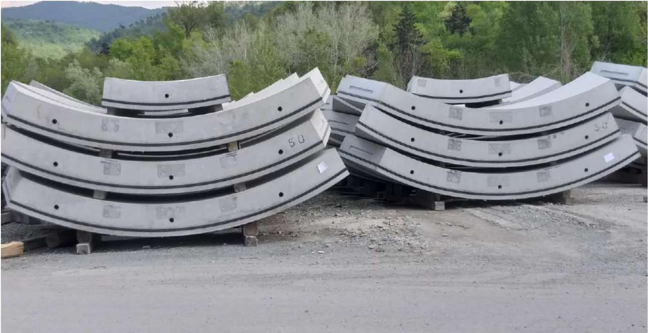
**Figura 3.** Fase di stoccaggio di conci prefabbricati
